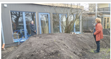
Rückseite des Mehrzweckgebäudes
